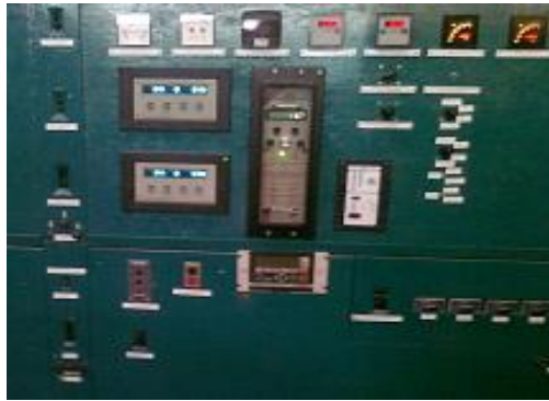
Figura 4.16 Fuente regulada trifásica para prueba de tensión de impedancia.
